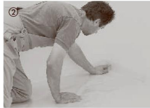
Ved cementgulve og ved udlægning på gulvvarme skal der principielt lægges en 0,2 mm tyk PE-folie, som skal overlapke 30 cm i kanten. Folien trækkes op ved væggen og skæres efter montering af fodlister af ved overkanten af disse.
