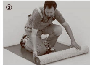
Til lydæmpning og til udligning af små ujævnheder lægges et 2 mm tykt komfortunderlag Silent. Se også andre isoleringsmaterialer i vort tilbehørstilbud. Asfaltpap er ikke egnet til trinlydisolering. Parket med pålimet isoleringsunderlag er ikke egnet til limning over hele fladen.
