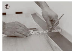
Elementerne i sidste række skæres til i længderetningen med en ekspansionsafstand på 10–15 mm og indpasses.
