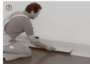
Start med resten af det afskårne stykke fra første række i den næste række (enderne skal forskydes min. 50 cm). Derved reduceres spildet meget. Lægningen fortsættes element for element. Først drejes elementerne på langs ind i samlingen med et let tryk.
