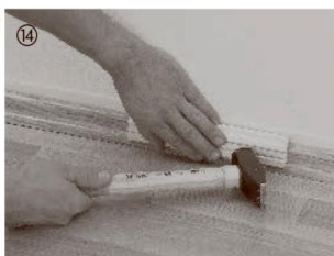
Efter lægningen skal afstandskilen fjernes. Fodlister (kan monteres med og uden clip-system) fastgøres til væggen – færdig.
