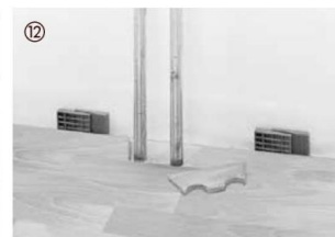
Til rørgennemføringer bores eller saves passende huller i elementerne. Størrelsen afhænger af det pågældende varmerør, og der skal tages højde for den nødvendige ekspansionsafstand.
