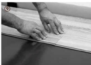
Derefter lægges elementet med enden først. Vær opmærksom på, at elementet støder helt op mod det tidligere lagte element i enden. Ved et kort tryk på tværsamlingen klikker elementet ind.
