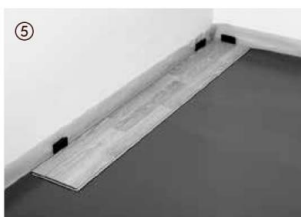
Lægningen startes i højre hjørne af rummet. Elementerne lægges med federsiden mod væggen og fikseres med afstandskiler (ekspansionsafstand til væg 10–15 mm).
