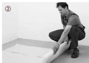
Ved alle cementgulve og ved udlægning på gulvvarme skal der principielt lægges en 0,2 mm tyk PE-folie, som skal overlappe 30 cm i kanten. Folien trækkes op ved væggen og skæres efter montering af fodlister af ved overkanten af disse.
