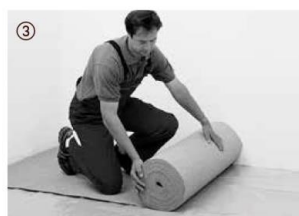
Til trinlydisisolering og til udligning af mindre ujævnheder udrulles et 2 mm tykt isoleringslag af kork uden buler. Se også andre isoleringsmaterialer i vort tilbehørstilbud. Asfaltpap er ikke egnet til trinlydisisolering. Ved HARO laminatgulv med Silent Pro® må der ikke anvendes yderligere isolering.
