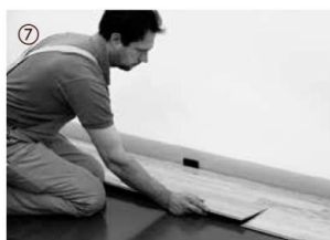
Start med resten af det afskårne stykke fra første række i den næste række (enderne skal forskydes min. 50 cm). Derved reduceres spildet meget. Lægningen fortsættes element for element. Først drejes elementerne på langs ind i samlingen med et let tryk.
