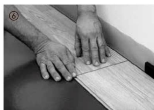
De øvrige elementer i første række skal klikkes ind oppefra i det forrige bræt ved hovedenderne. Ved et kort tryk på tværsamlingen klikker elementet ind i det tilstødende element. Vær opmærksom på, at elementerne flugter nøjagtigt. Det sidste element i første række tilskæres og indsættes, idet der tages højde for en ekspansionsafstand på 10 – 15 mm til væggen.
